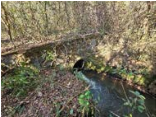
Foto 69 C-PC-098 Ponto controle com manilha embaixo de ponte antiga apresentando uma drenagem ativa, vegetação antropizada e sem registros de afloramentos rochosos.
