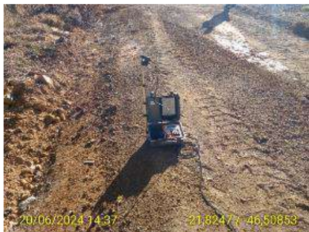
Foto 42 Registro da Instalação do Equipamento – VB-10
